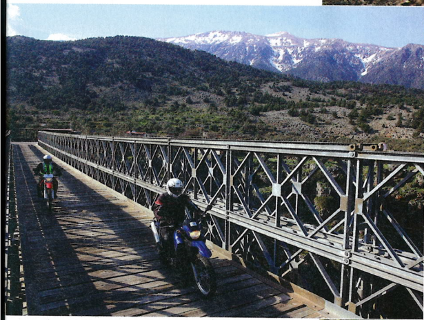
Da klammert sich der Knipser eisern ans Eisen: Beim Befahren gerät die Brücke über den Aradenas-Canyon förmlich in Schwingung
